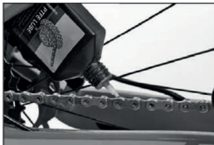
Łańcuch należy nasmarować po oczyszczeniu.
